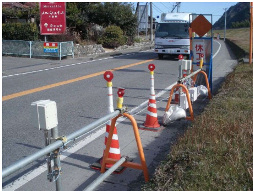
単管バリケードを利用し設置
