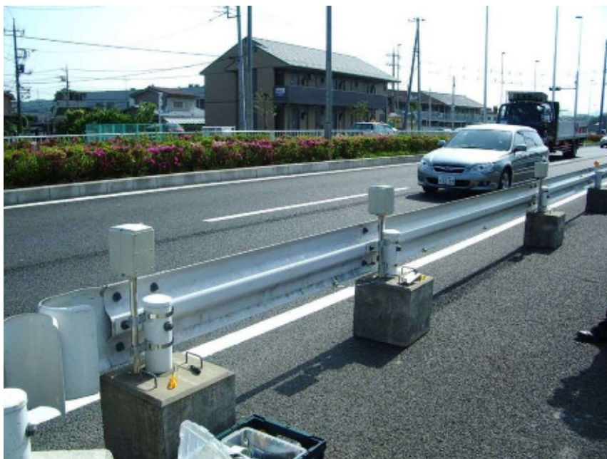
ガードレールに設置
