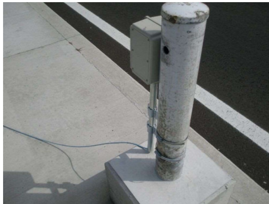
簡易支柱を利用し設置
